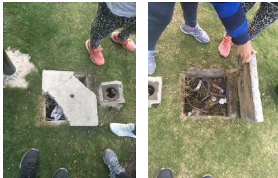
Figura 32. Detalle de las tapas de la plaza entre conjuntos habitacionales de Containera.
