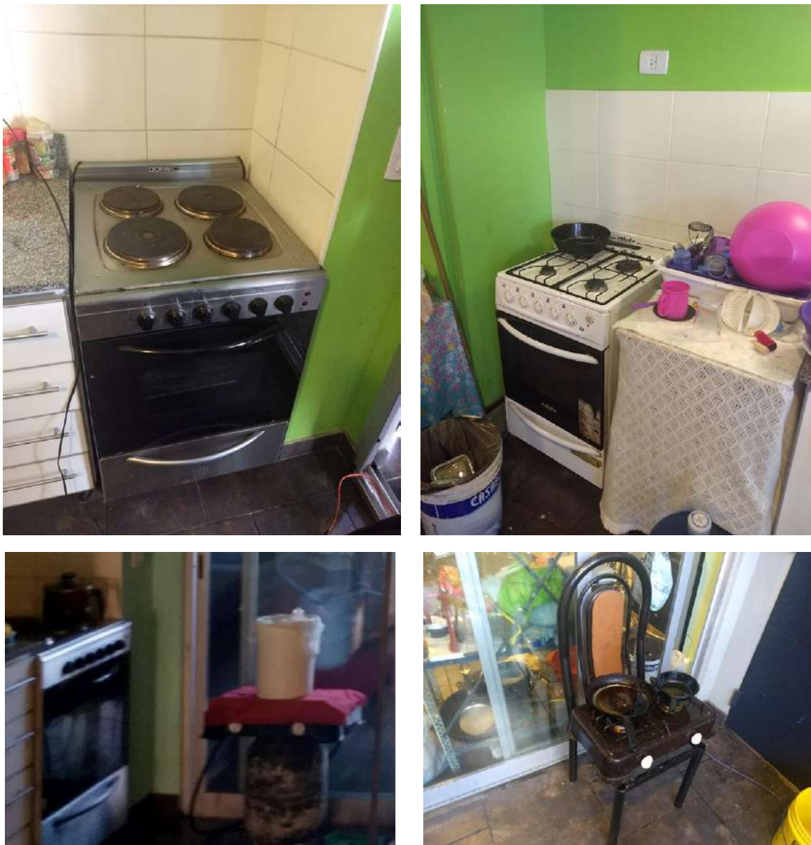
Figura 38. Como les resulta imposible cocinar con las cocinas eléctricas recurren a cocinas o mecheros adicionales con garrafa. La segunda imagen ilustra el caso de una familia a la que no le funciona la cocina eléctrica y como no se la han reparado, instalaron una con garrafa en el sitio dispuesto para la heladera. En la segunda y tercera imagen se ven los típicos mecheros adicionales con garrafa.
