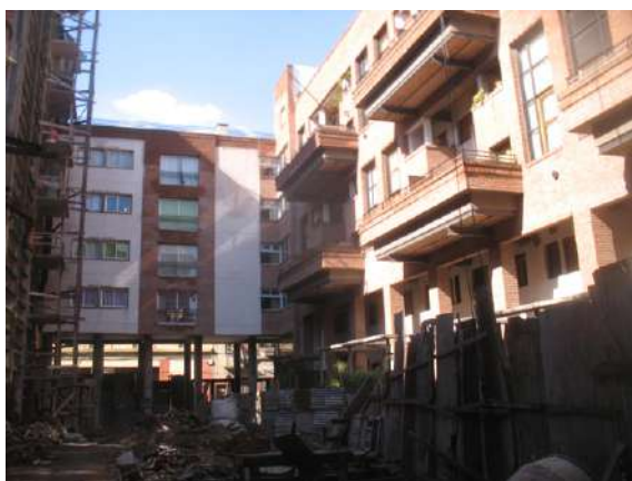
Figura 2. Patio interno de la cooperativa (lado Solís), con las primera y segunda etapas terminadas y la tercera en obra (foto tomada en agosto de 2015).
