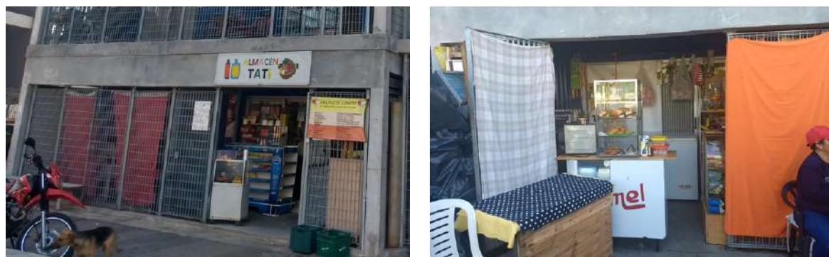
Figura 39. Las imágenes ilustran el caso de dos comercios que se despliegan en un espacio extremadamente reducido e inadecuado para la actividad comercial, desprotegido del exterior y que además obstruye la iluminación y ventilación del living-cocina-comedor.
