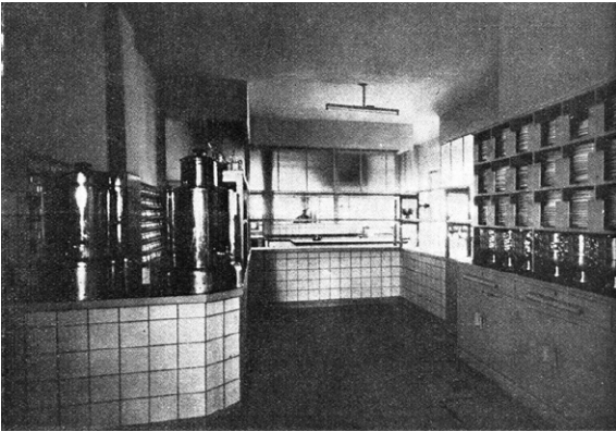
Figura 9. Vista de la Cocina: Primer Piso.
