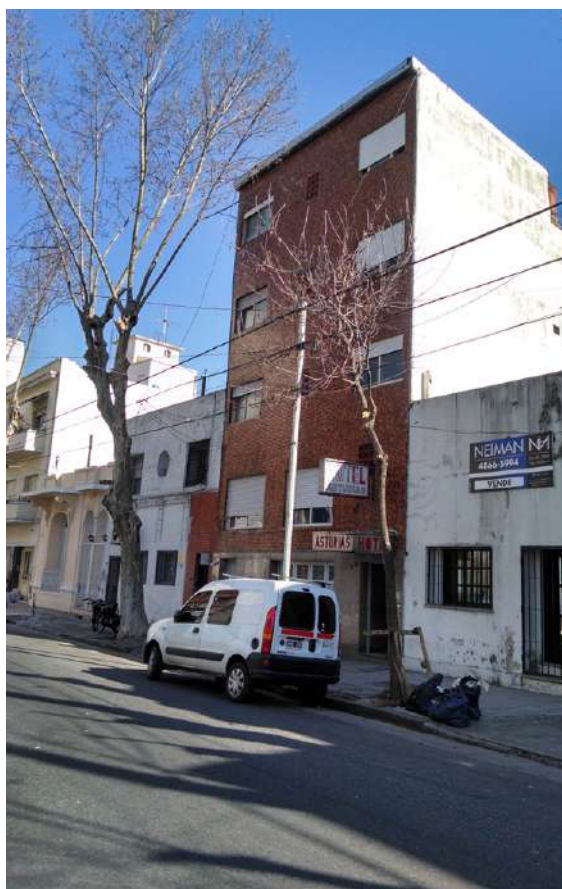
Figura 14. Frente del "Hotel Asturias" que es un edificio específicamente construido como hotel.
