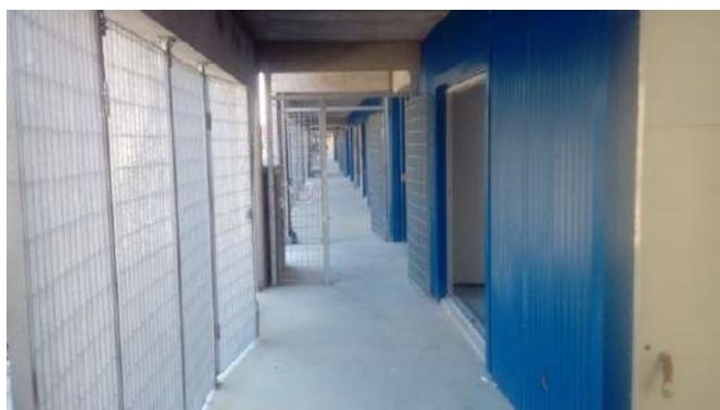
Figura 22. Vista desde el balcón de la última vivienda del conjunto hacia la puerta de acceso en la etapa final de construcción. Esta es la imagen con la que se encontraron los futuros habitantes en las visitas y que desencadenó tanto rechazo.
