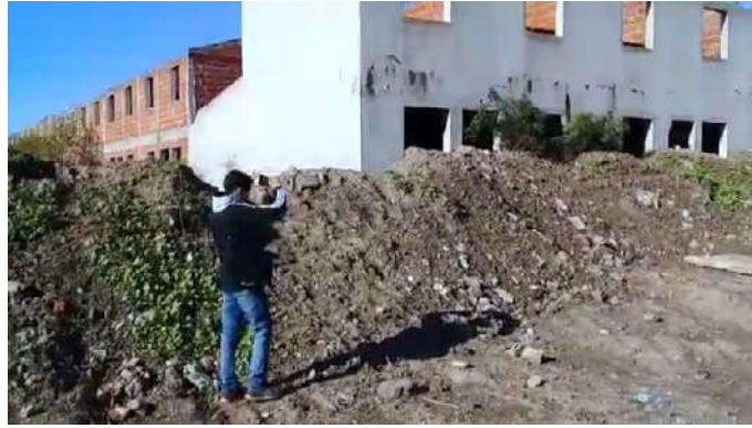
Figura 4. Un vecino fotografiando las ruinas del complejo habitacional de Calle 24 y Pasaje Reconquista.
