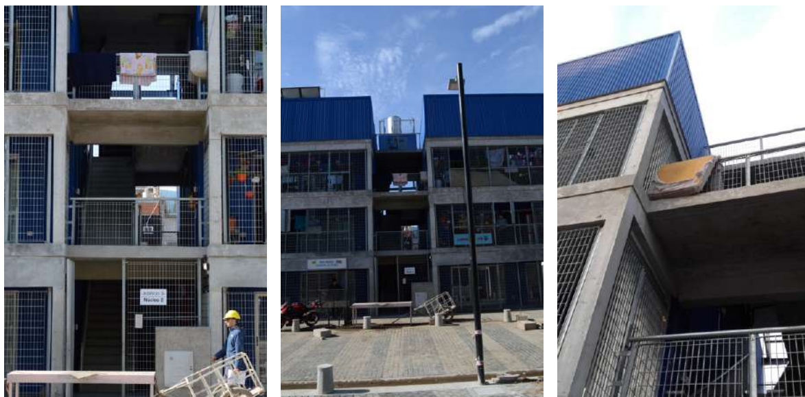
Figura 20. Vista del núcleo de escaleras y del palier de acceso a las viviendas desde el exterior.
