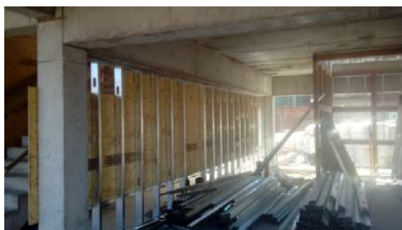
Figura 24. Vista del sistema de muros en uno de los departamentos adyacente al núcleo de escaleras.
