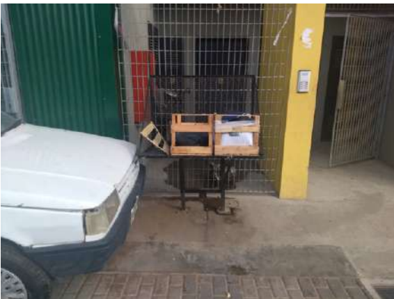
Figura 31. A la falta de cestos de basura en el espacio público se suma el diseño de los cestos de los edificios que deja la basura al alcance de los animales domésticos y las plagas. En este edificio la basura se derrama sobre el agua desbordada de la tapa de desagüe que está debajo, generando constantes malos olores y proliferación de gusanos y todo tipo de insectos.
