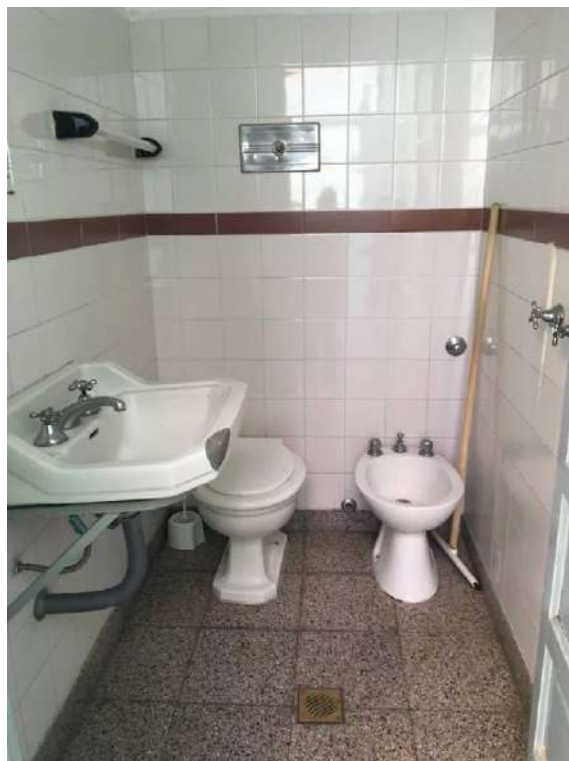
Figura 25. Interior de baño "Hotel Carames"
