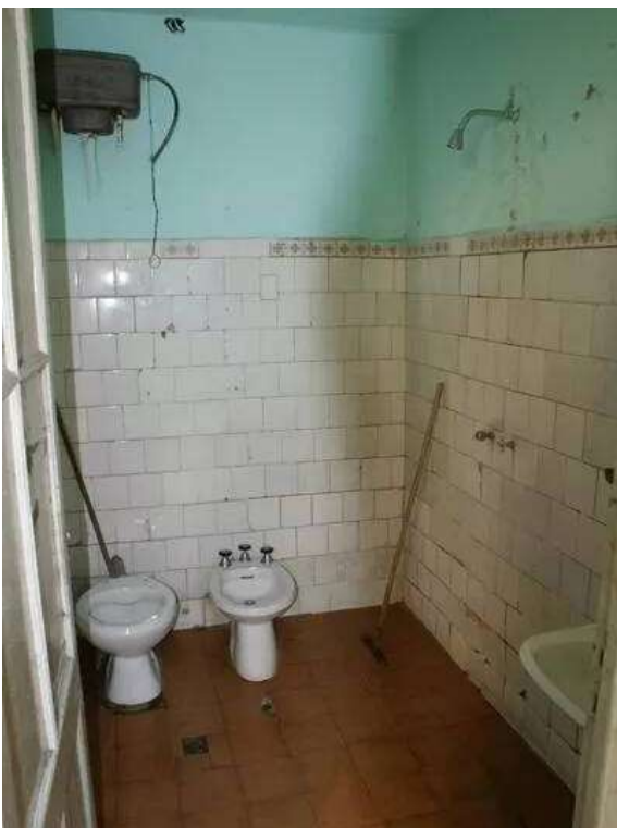
Figura 24. Interior de baño "Hotel Bahía"
