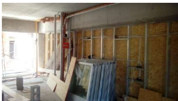
Figura 23. Interiores de los muros con instalaciones.
