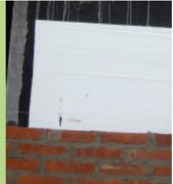
Foto 3 K = 0,75 \text{ W/m}^2\text{k} VERIFICA LEY 13059
