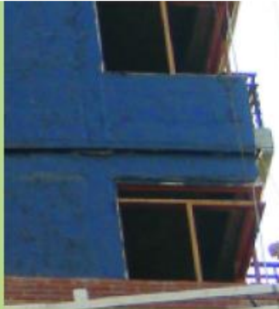
Foto 2 K = 1,3 \text{ W/m}^2\text{k} NO VERIFICA LEY 13059
