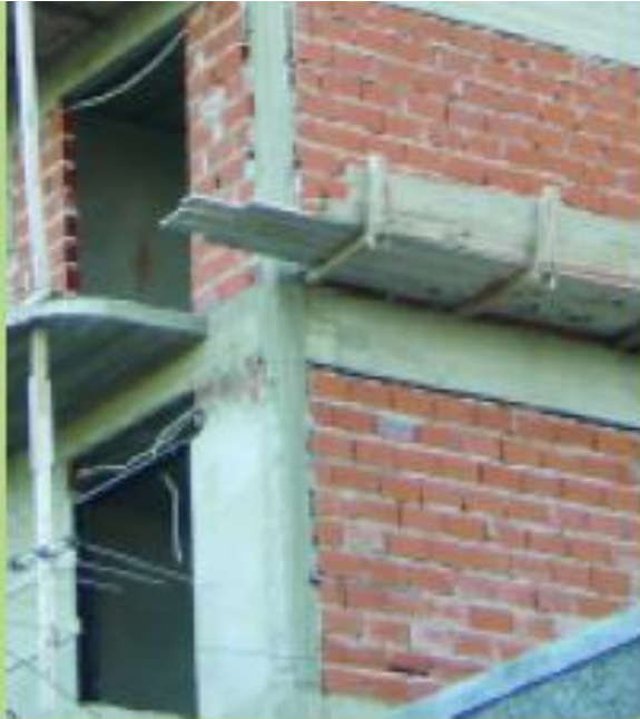
Foto 1 K = 1,5 \text{ W/m}^2\text{k} NO VERIFICA LEY 13059
